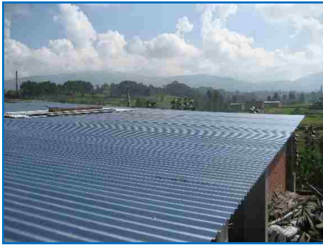
Le toit de l'école est terminé
