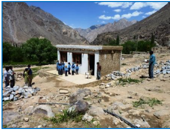
L'école de Lasthang, construite en 2004
